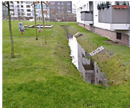
Mulden unterstützen den Wasserrückhalt
