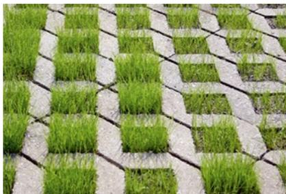
Durchlässige Pflasterung fördert die Versickerung
